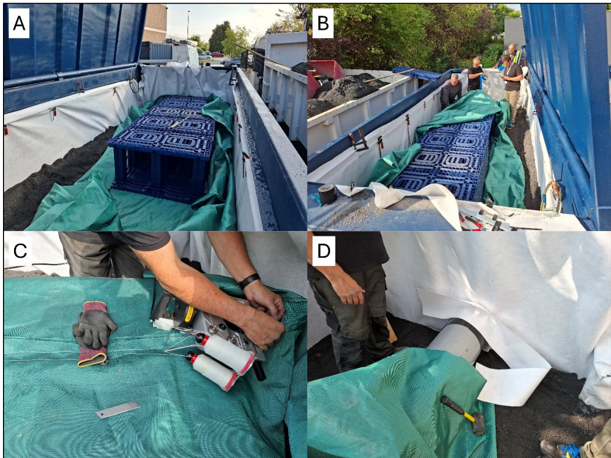
Figure 3 : Installation des structures alvéolaires ultra-légères dans le conteneur d'infiltration. A : Pose des premiers caissons sur la couche compactée de fondation, et sur un géotextile de filtration de type 5.3 (COPRO, 2024) ; Ensemble des sept caissons emboîtés et reliés aux ouvertures de chaque côté du conteneur ; C : Fermeture du géotextile de filtration par coutures mécaniques et lignes de colle à chaud ; D : étanchéification des tuyaux de connexion par des bandes géotextiles et des lamelles de caoutchouc.
