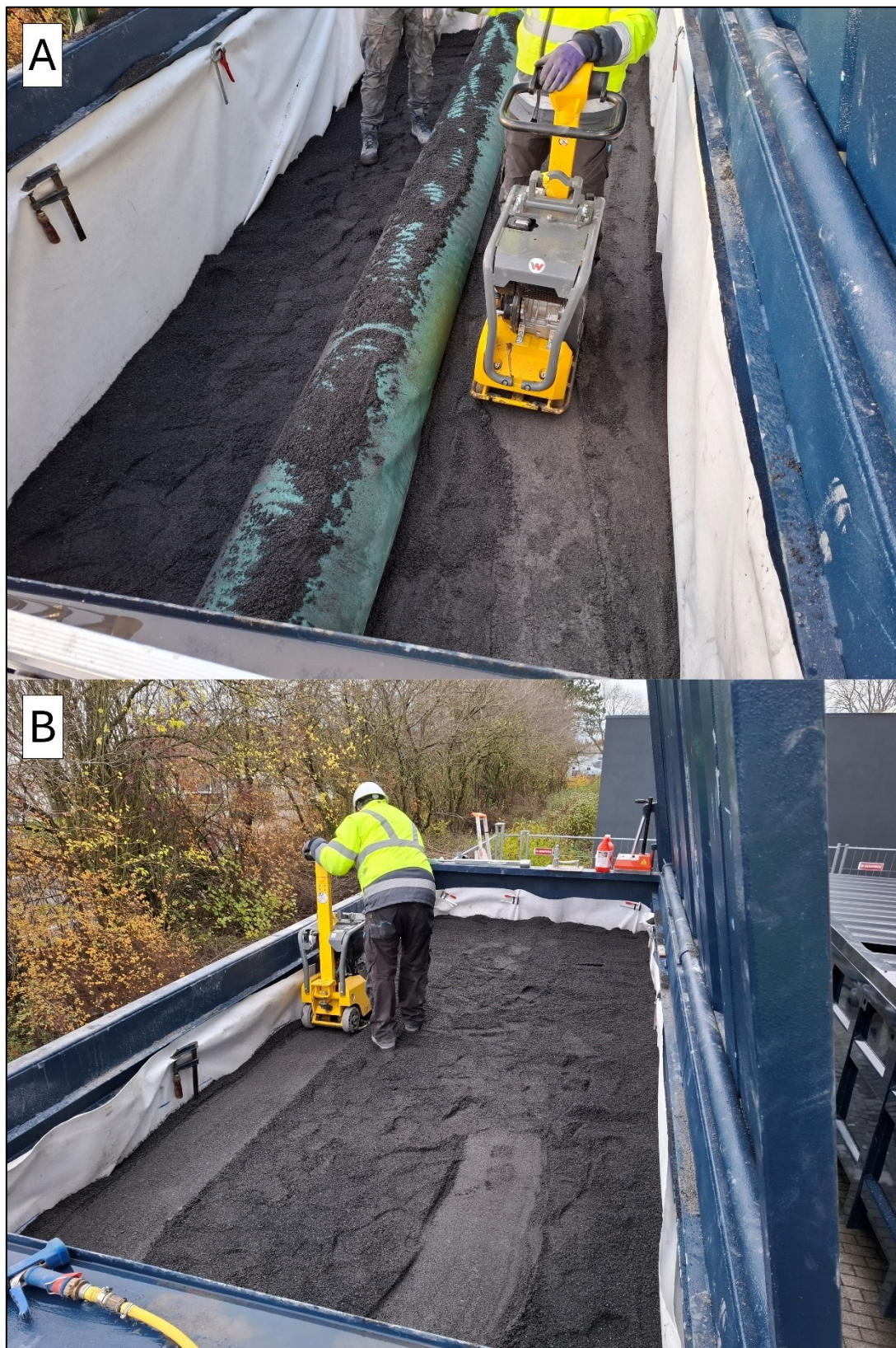
Figure 4 : Installation du tuyau perforé en PP et remplissage du conteneur d'infiltration. A : Répartition d'une couche de sable autour du tuyau en PP fraîchement posé ; B : Compactage à la plaque vibrante de l'avant-dernière couche de sable d'infiltration.
