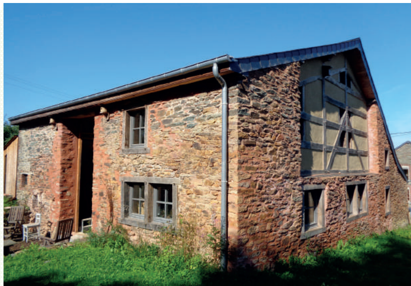
▲ Mur refait en colombage.
