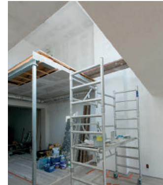
▲ Plancher recoupé pour le premier étage.
