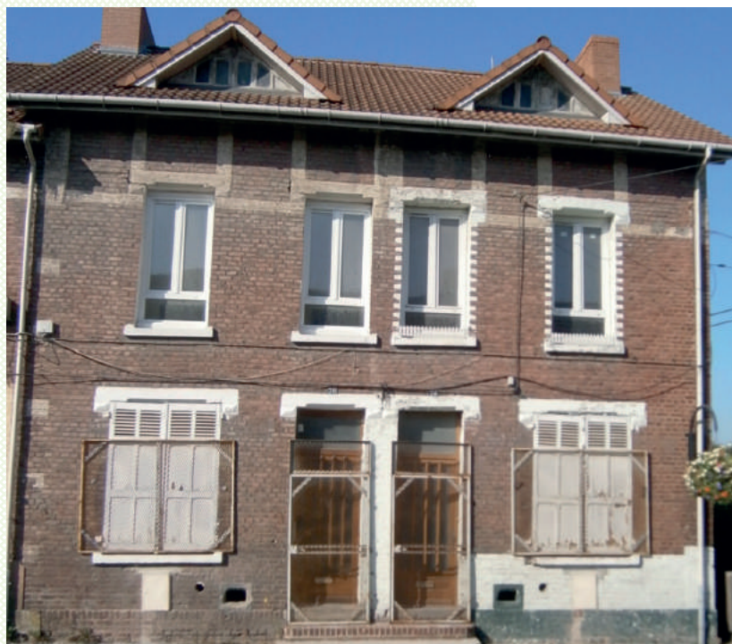
▼ Habitations typiques du bassin minier.
