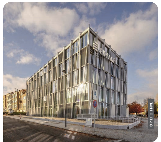
Le nouveau siège d'Eiffage Construction Belux à Bruxelles.
