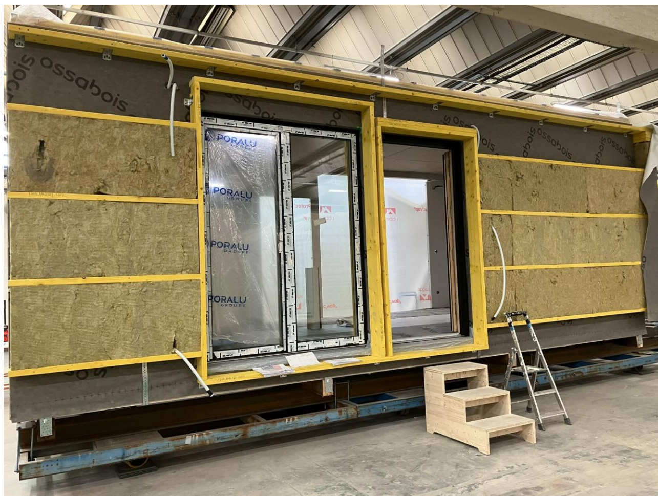
Figure 6 Un des modules pour le programme de 42 logements à Wiltz (Luxembourg) emmené par le groupement Oikos-concept, Polygone Luxembourg, Banice Architectes, Ossaboïs, Luxplan et BSC – Financé par le Fonds du Logement et par la Commune de Wiltz
