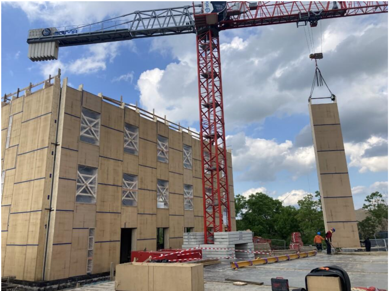
Figure 5 Composants de façade Pailletech pour les bureaux Dellizzotti à Bettembourg (Luxembourg)
