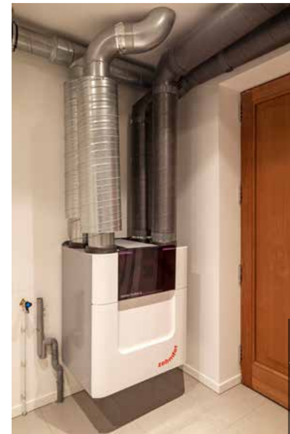
Vu leur encombrement plus important, les systèmes double flux se prêtent mieux aux nouvelles constructions qu'aux rénovations.
