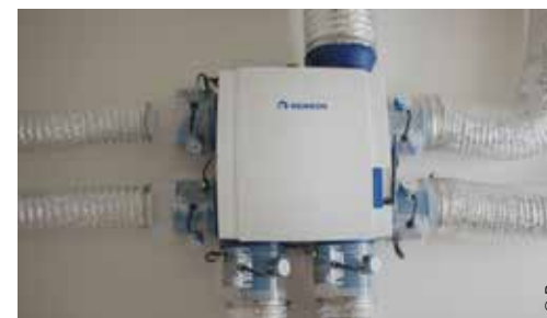
Les systèmes C pilotés à la demande fonctionnent sur base de détecteurs (CO 2 , humidité...) qui adaptent le débit de ventilation aux besoins du moment.
